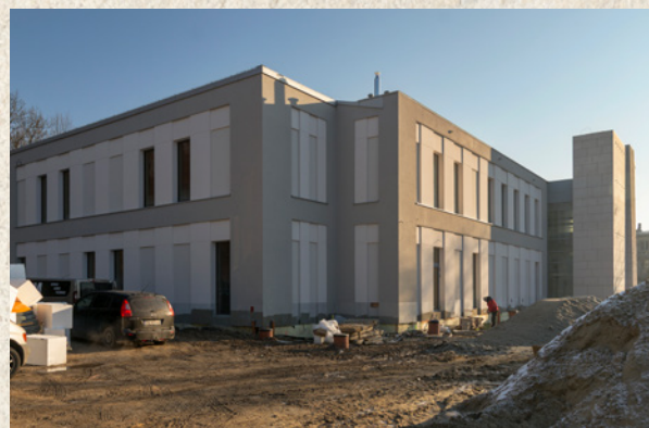
Budowa sali gimnastycznej przy budynku LO w Krzeszowicach (dawnym hotelu łaźniakowym uzdrowiska), Zdjęcia: Krzysztof Kamiński
