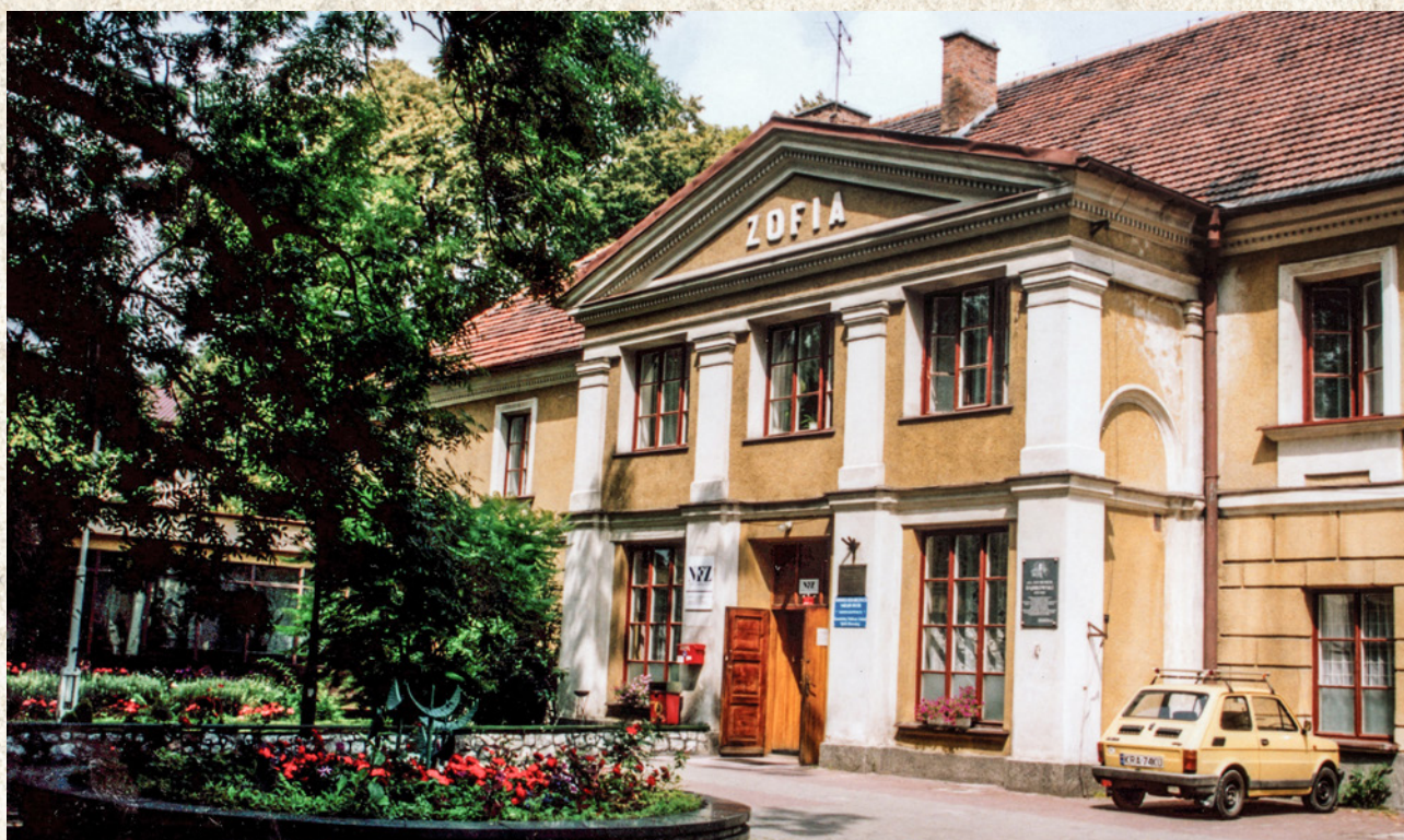
Budynek łazienek „Zofia” przed remontem. Zdjęcie z archiwum UM w Krzeszowicach
