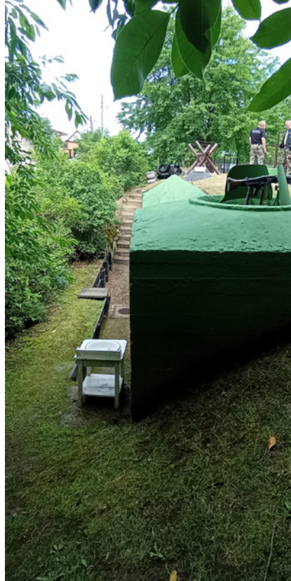
Schron w Rudawie - widok z zewnątrz
