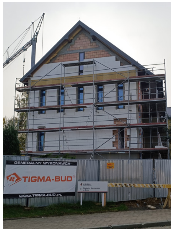
Rozbudowa Zespołu Szkół i Placówek Oświatowych w Skale
