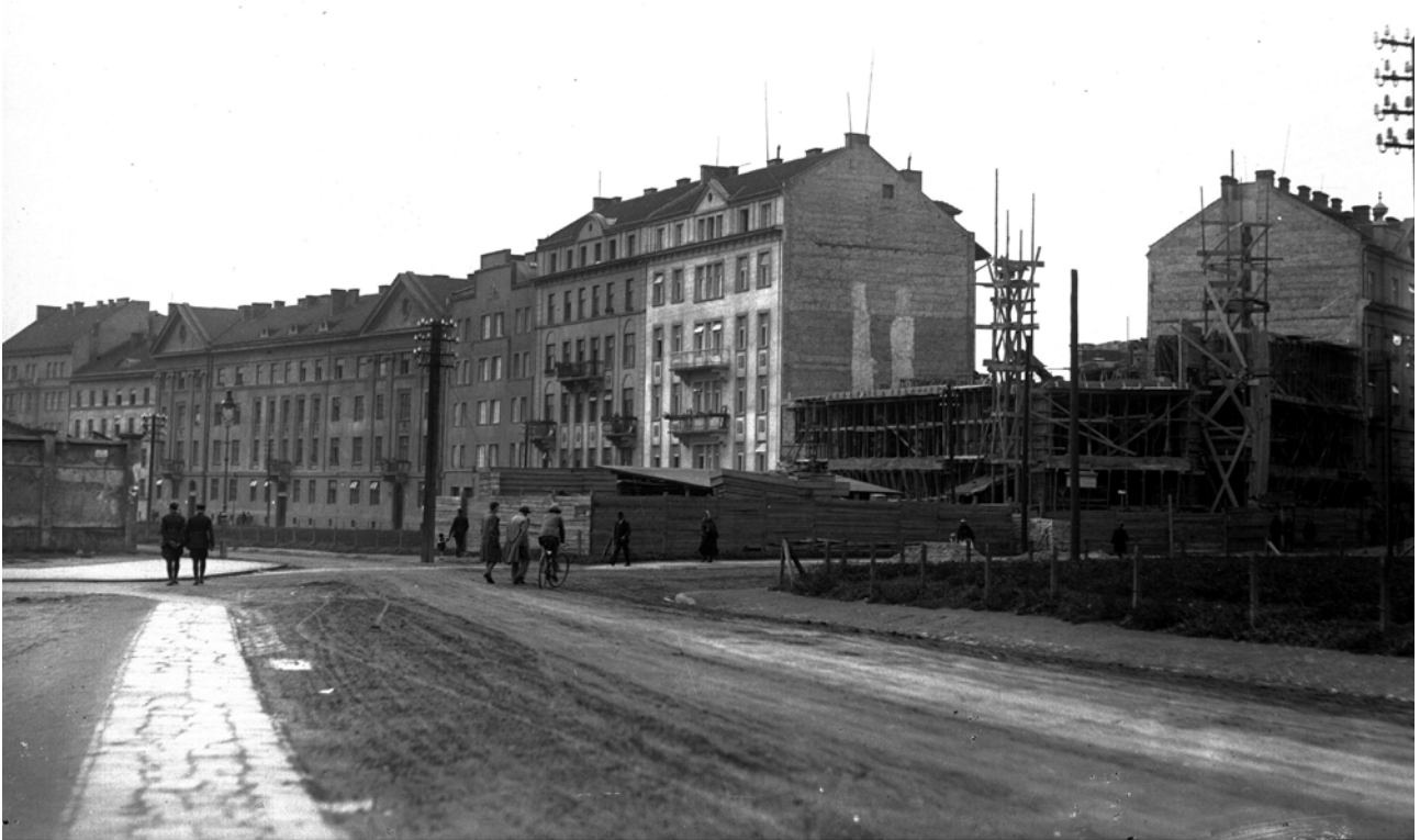
Aleja Słowackiego w latach 30. XX wieku, widoczna budowa dzisiejszej siedziby Starostwa Powiatowego w Krakowie. Zdjęcie: Narodowe Archiwum Cyfrowe, sygn. 3/1/0/9/2623a
