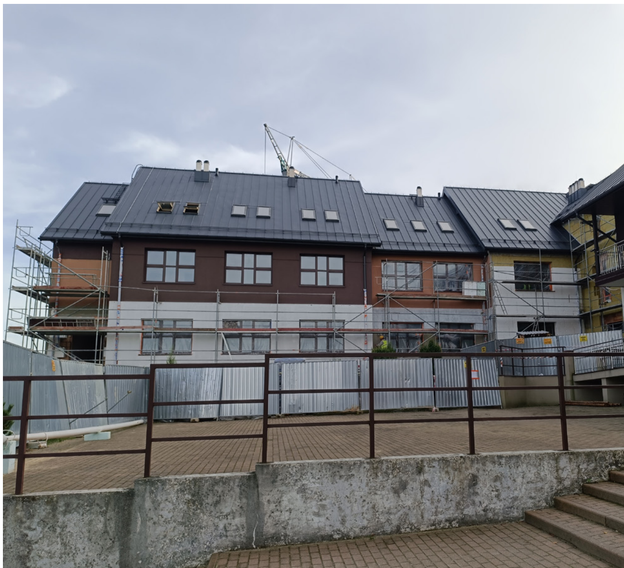
Rozbudowa Zespołu Szkół i Placówek Oświatowych w Skale
